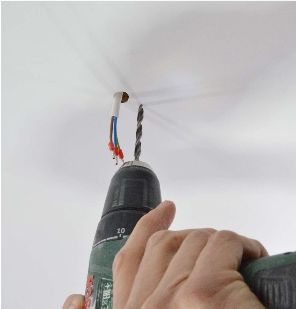
3. Bohren Sie die Löcher mit einem 5 mm Bohrer und
